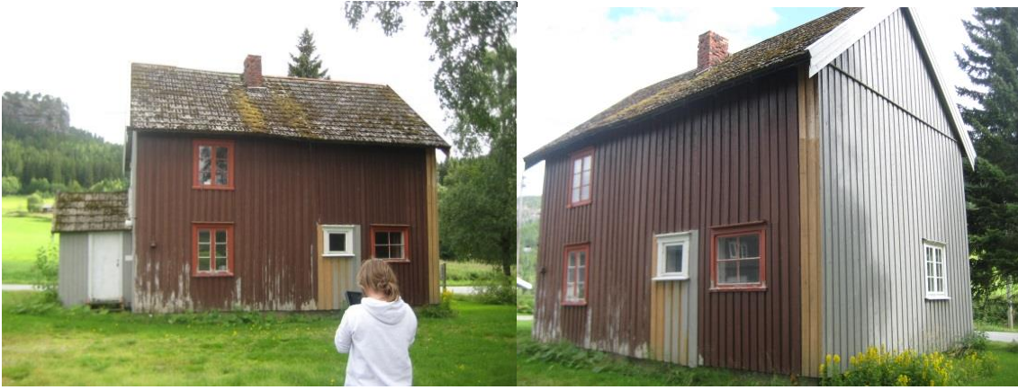
Krets 1 Vassbotn. 93/22 Nymoan. Tidligere husmannsplass. Huset er under istandsetting. Bygningen er en av få med original takstein.
